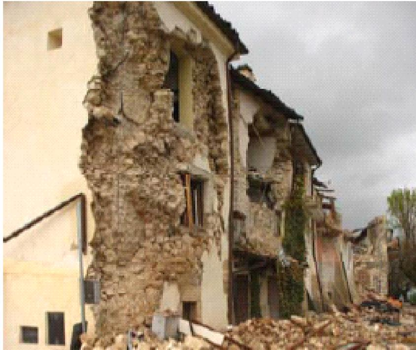
Il meccanismo si manifesta con formazione di una cerniera cilindrica orizzontale che divide la cortina esterna di una parete, compresa tra due solai efficacemente connessi alla muratura ed un orizzontamento intermedio non collegato, in due blocchi ed è descritto dalla rotazione reciproca degli stessi attorno a tale asse per azioni fuori dal piano.
